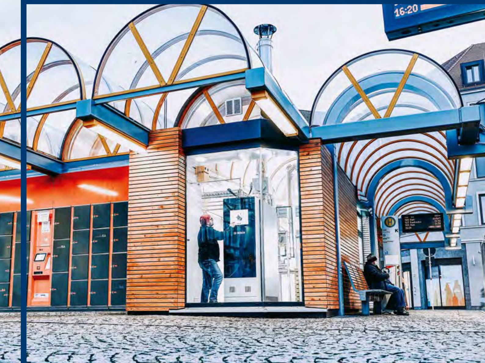
STATIONÄRE BRENNSTOFFZELLE (SOFC) am Omnibusbahnhof Bamberg
